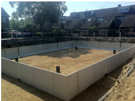
De keerwanden worden geplaatst en worden voorzien van duurzaam drainage materiaal.
