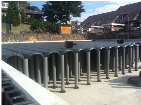
Plaatsing van het Watershell systeem tussen de keerwanden.
